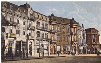
Clădiri în Piața Ovidiu, Constanța , arhitecți necunoscuți, cca. 1900–1910, demolate în anii '80 cu excepția celei neoromânești din dreapta, parte a procesului de sistemizare
